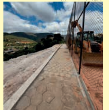
Muro de contenção no Campo Aníbal Herculano
